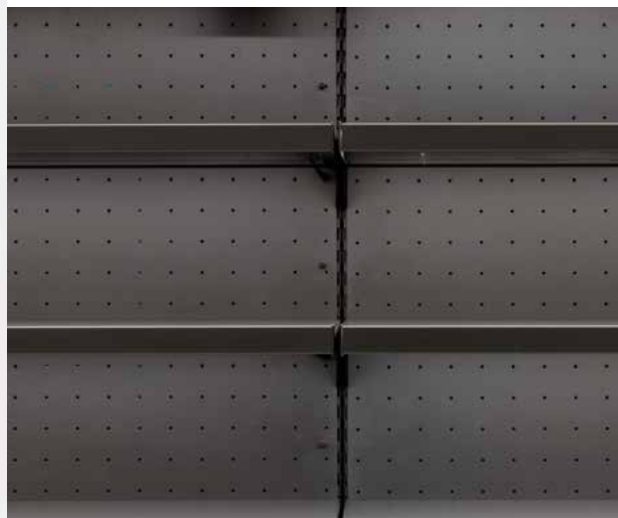
Canalizzazione moduli in continuità
